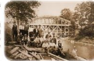
Canal bridge in construction Source : archives départementales
