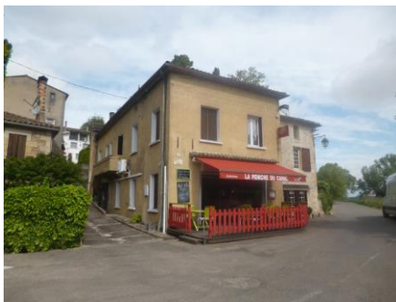
La péniche du canal – Meilhan-sur-Garonne
