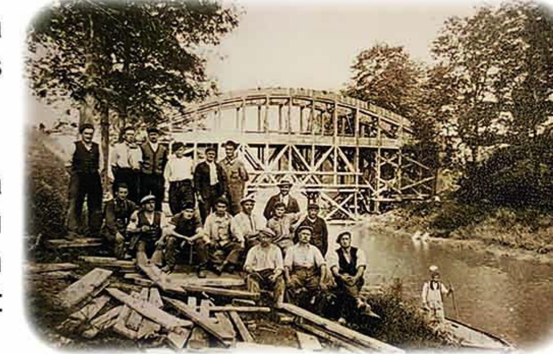
Pont du canal en construction Source : archives départementales
