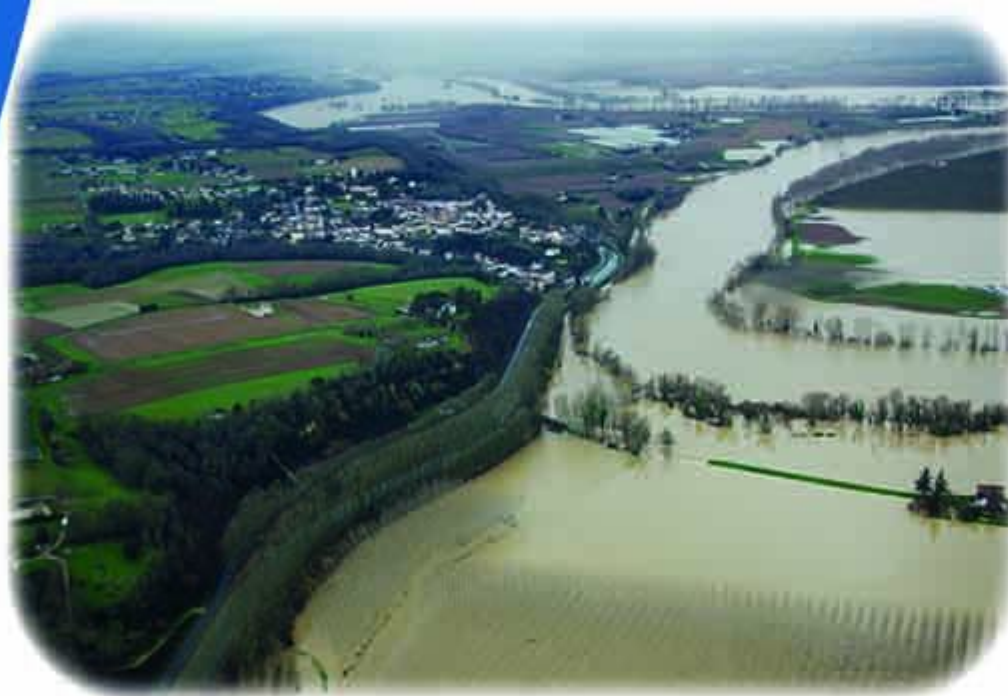
Le déversoir de Meilhan lors d'une crue
