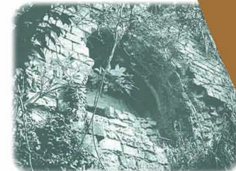
Issue du tunnel de Meilhan
