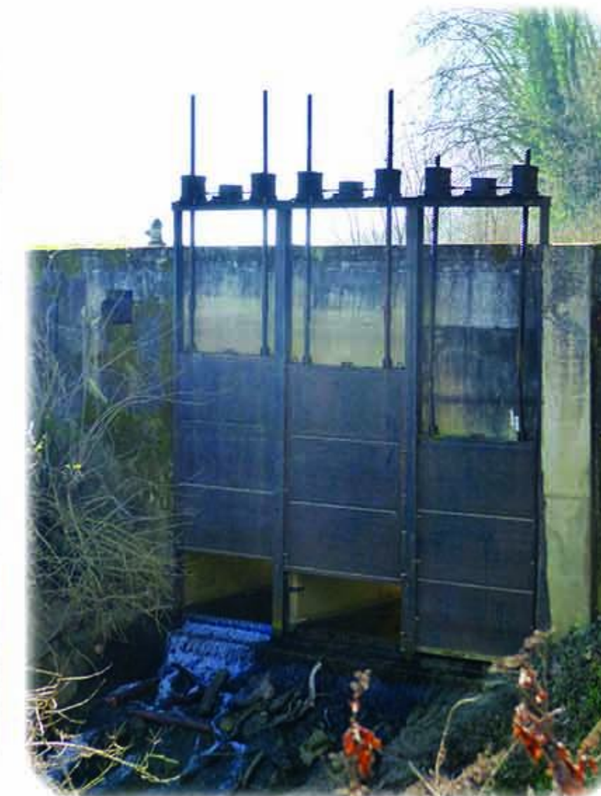
Pelles et déversoir du Baqueyron
