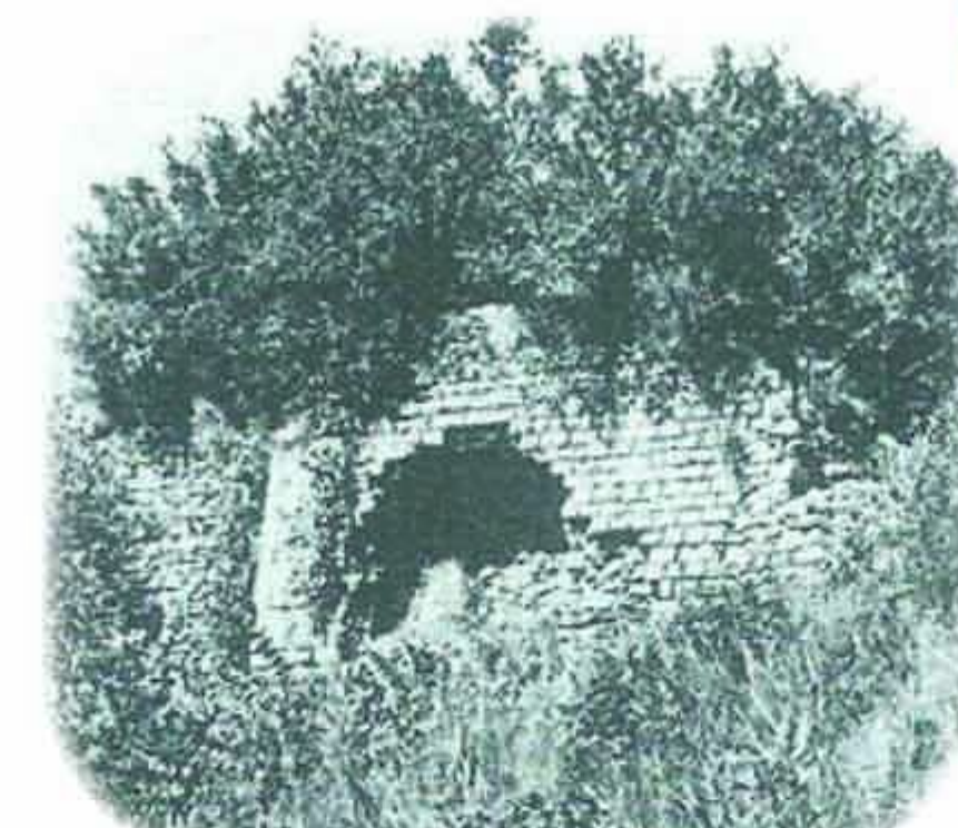
Entrée du tunnel de Meilhan
