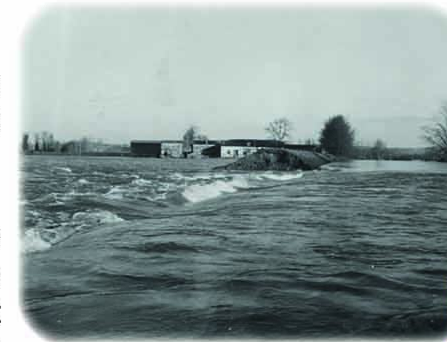
Rupture de digue
