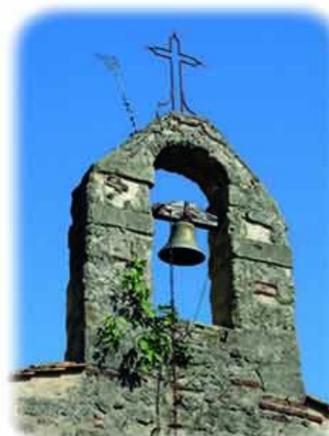
Clocher-mur de la chapelle de l'hospice
